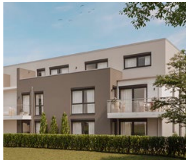
Beim Neubauprojekt in Langenbrand hat hochwertiges Wohnen höchste Priorität. Der Großteil der Wohnungen ist bereits verkauft.
